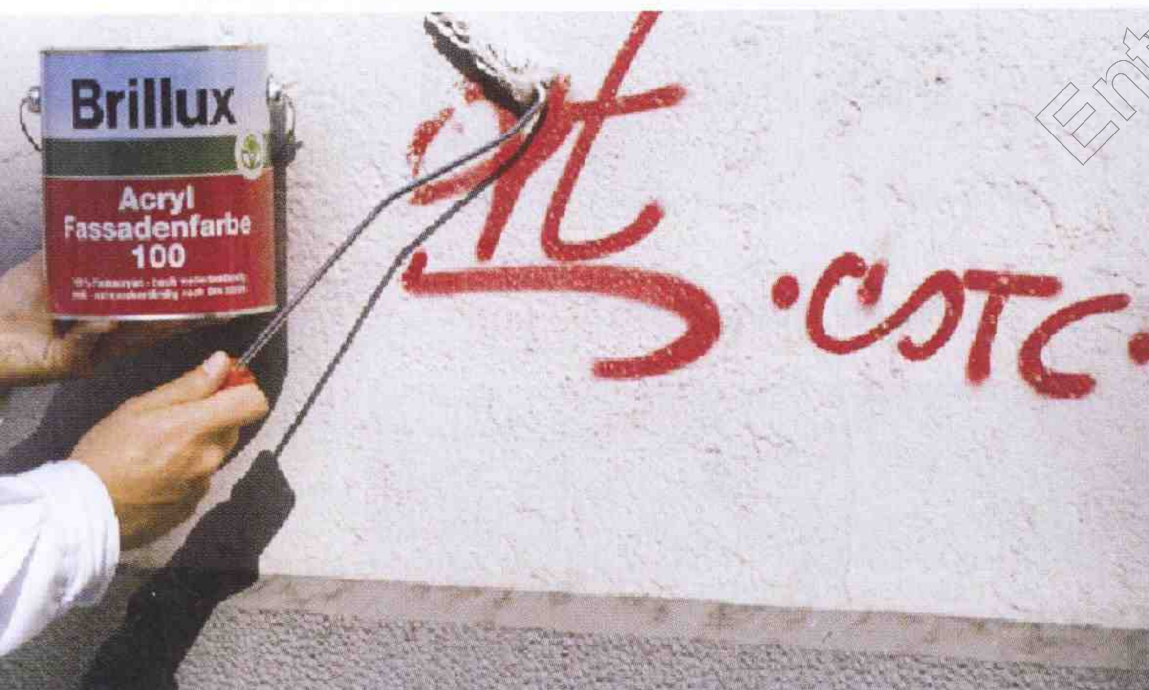
Überstreichen mit der angefertigten Farbtonrezeptur
