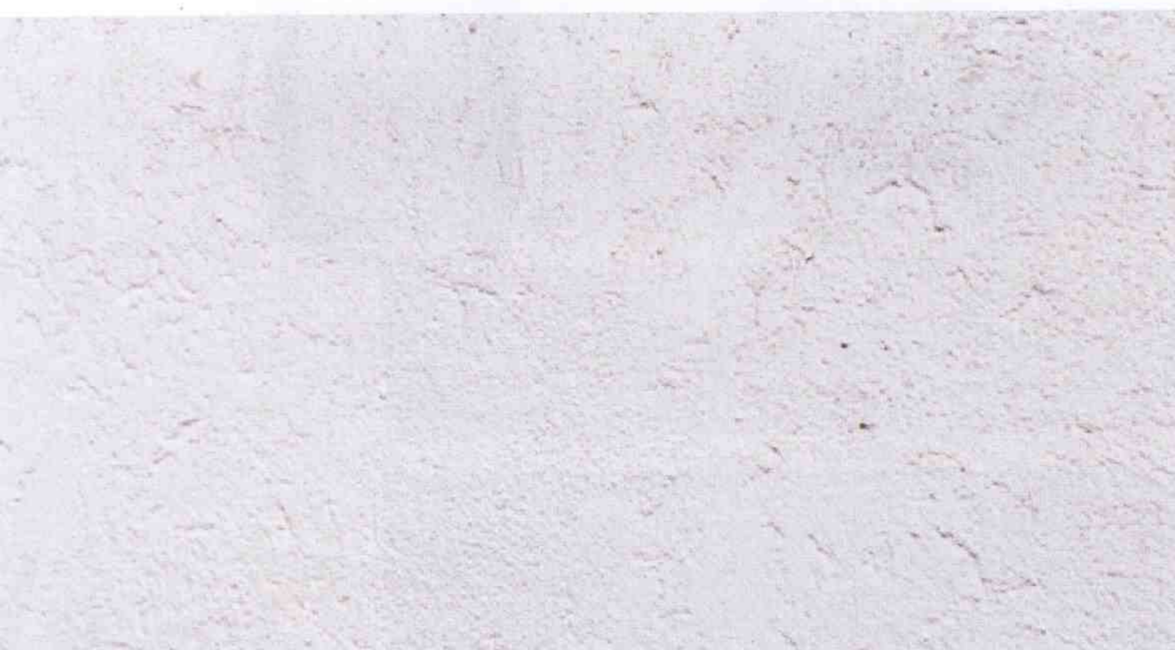
Kostengünstige Graffitibeseitigung: Die Fassade ist partiell saniert
