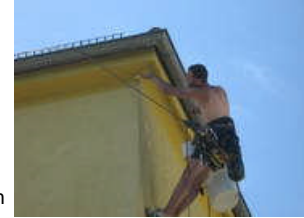
Farbneutrale Spechtlochanierung in einem Berliner Vorort durch Seilkletterer (Foto: Colour Clean)
